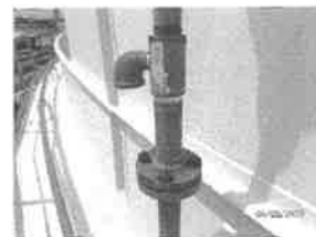
รูปที่ 40 ภาพถ่ายบริเวณของ bolts & nuts ของ foam chamber
