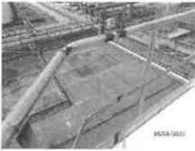
รูปที่ 15 พบการกัดกร่อนที่บริเวณของ Top wind glider
