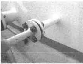
รูปที่ 21 พบการกัดกร่อนที่ flange, bolts & nuts ของ shell nozzle
