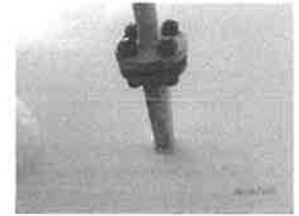
รูปที่ 18 พบการกัดกร่อนที่ shell nozzle และ bolts & nuts
