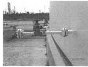
รูปที่ 17 พบการกัดกร่อนที่ shell nozzle และ bolts & nuts
