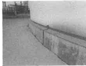
รูปที่ 4 สภาพของพื้นที่เชื่อมของถัง
