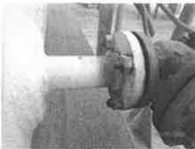
รูปที่ 23 พบการกัดกร่อนที่ bolts & nuts ของ shell nozzle
