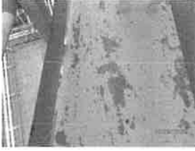
รูปที่ 13 พบร่องรอยการกัดกร่อนที่ Top wind glider
