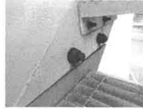
รูปที่ 27 ภาพระยะใกล้ของการกัดกร่อนที่ bolts & nuts ของ flange
