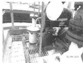
รูปที่ 28 ทำการวัดความหนาของเหล็กด้วย Ultrasonic Thickness Measurement.
